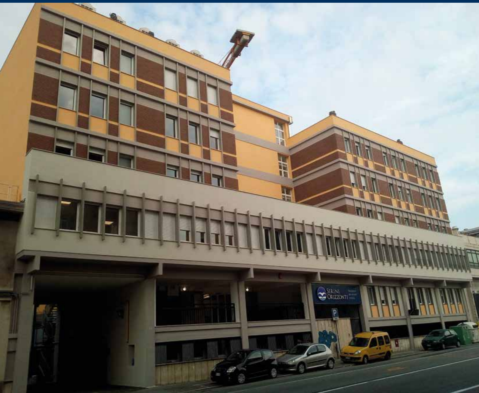
NUOVA STRUTTURA GENOVA
