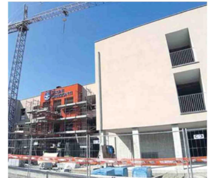
Il cantiere della casa di riposo in via Brunelleschi
