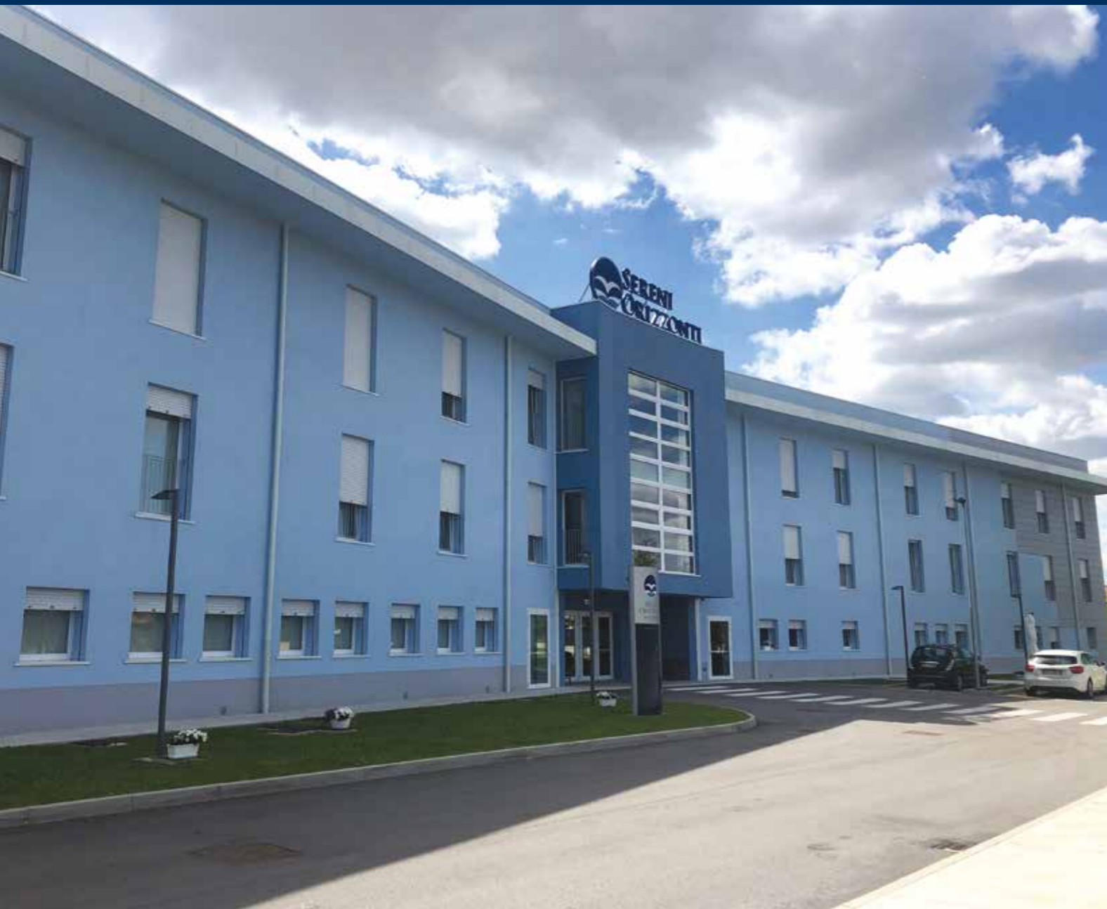
STRUTTURA 2018 TORRE DI MOSTO (VENEZIA)
