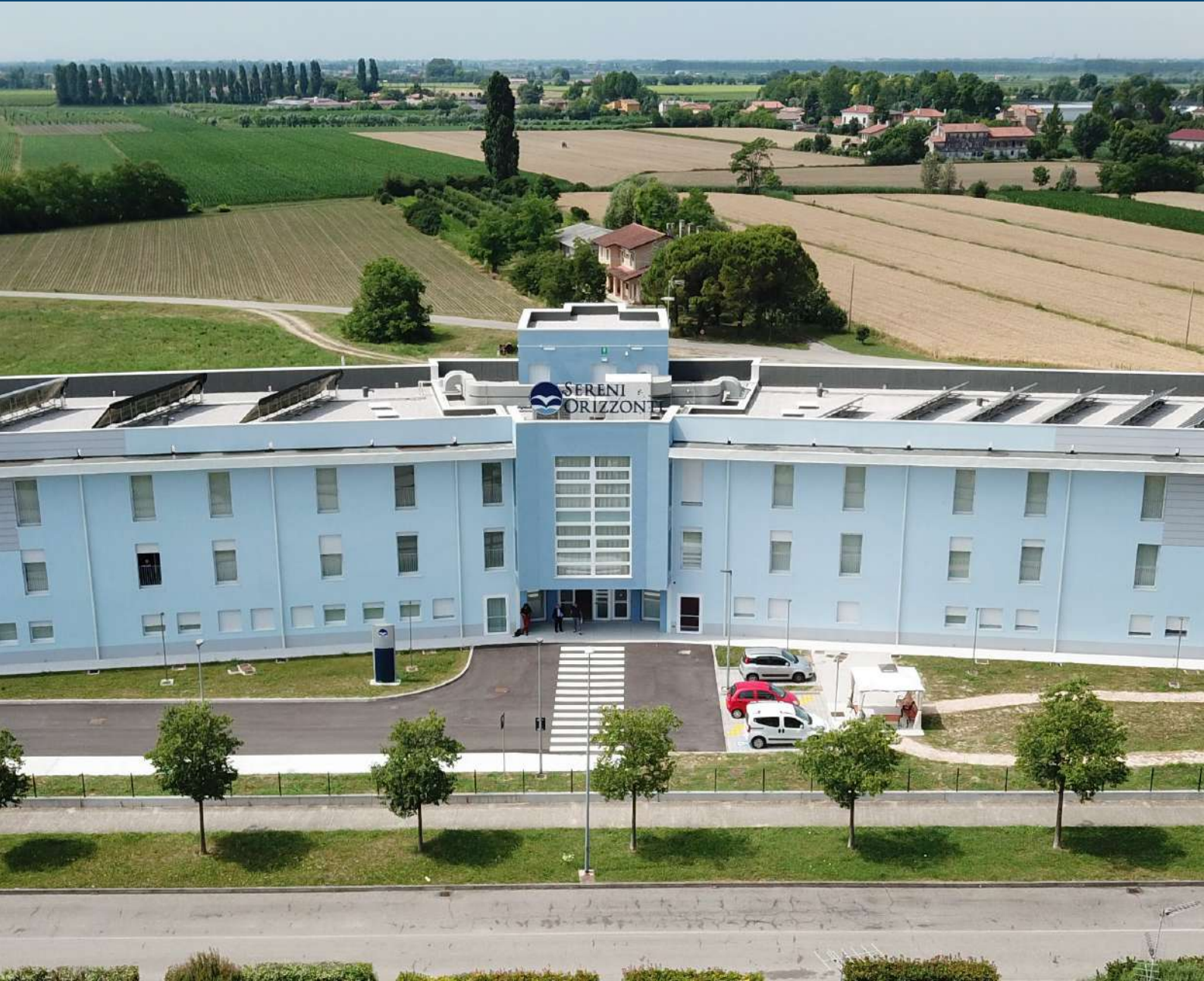
2018 FACILITY TORRE DI MOSTO (VE)
